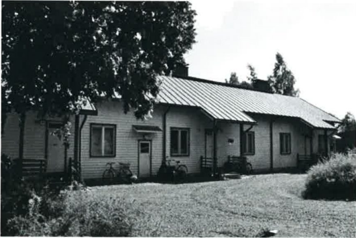
Kuva 4. Pajakadun rivitalon julkisivua (kuva rakennusinventointi).
