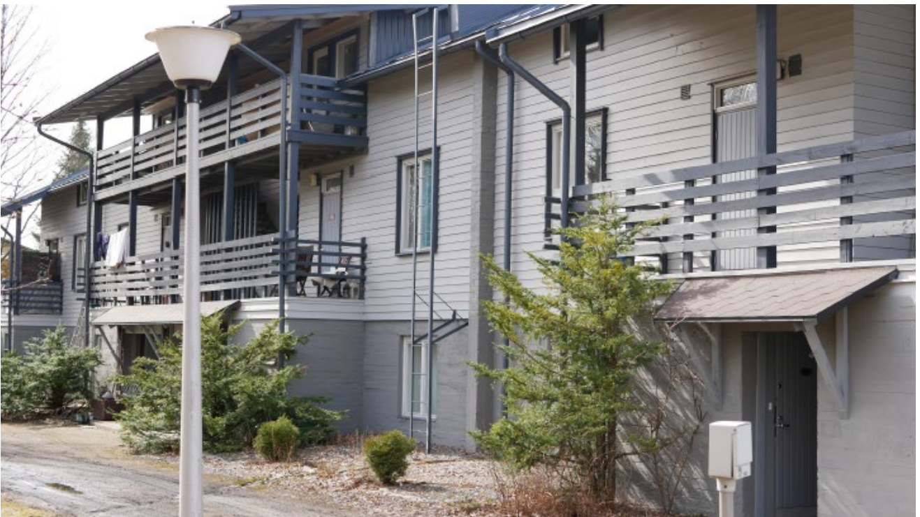
Pajakadun julkisivua pihan puolelta.
