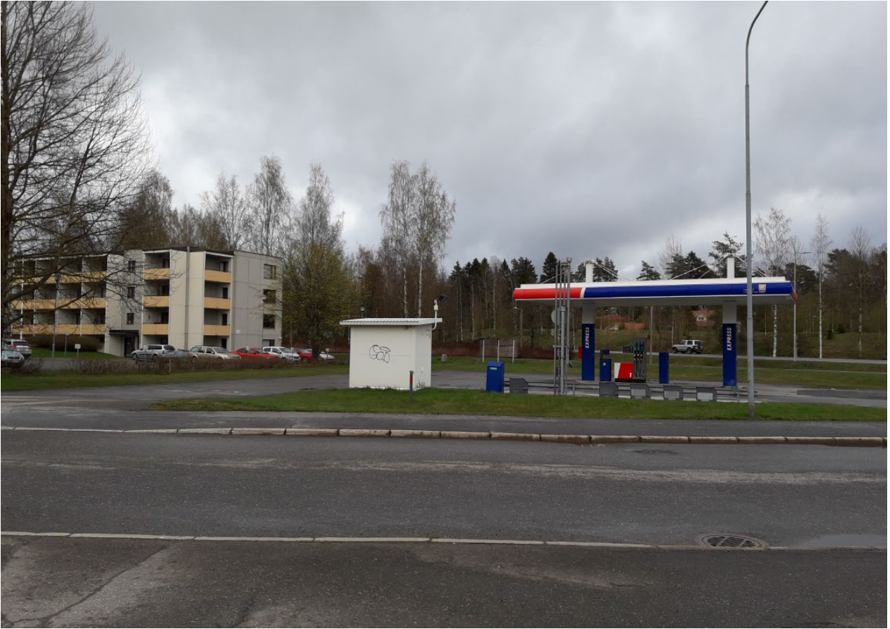
Juvantien ja Peitsarinkuja väliselle alueelle jäävä kylmäsema sekä alueen korkeampaa rakentamista.
